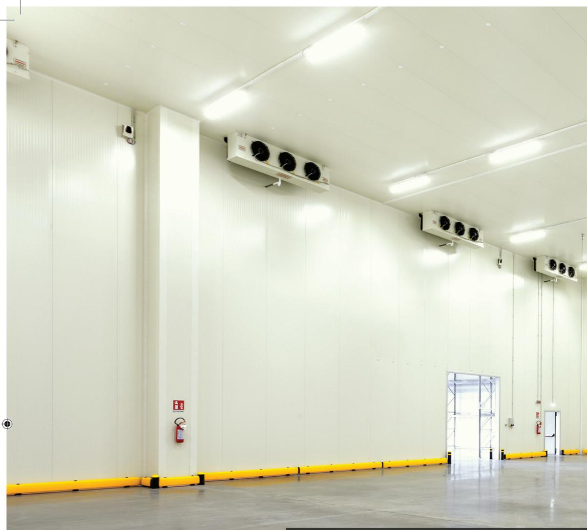
Hub23 è stato concepito secondo gli standard tecnologici più innovativi, con soluzioni capaci di garantire il perfetto mantenimento della catena del freddo in tutte le sue fasi. In particolare, nella struttura sono presenti più di 1.700 m<sup>2</sup> dedicati a celle refrigerate a -20° C per lo stoccaggio dei surgelati.
